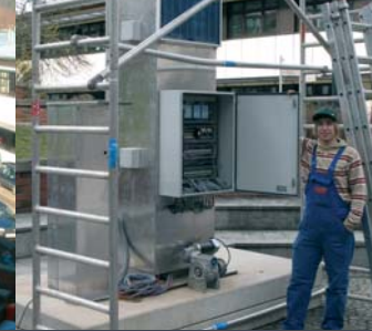
Aufstellen des Messgeräteliftes im Schulhof zwecks Endmontage und Inbetriebnahme
